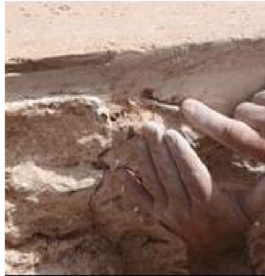
شکل ۱۱. تفکیک مرز میان لایه گچ حفاظتی و سطح گچ‌بری اصلی از طریق عقب‌نشستن و زیره‌سازی اندود حفاظتی.
