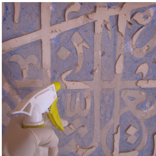
شکل ۴۲. تثبیت نهایی بخش های بازسازی شده با محلول پارالوئید (عکس از نگارنده)
