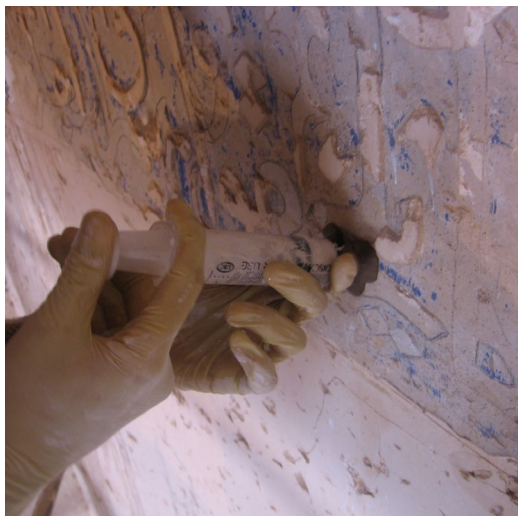
شکل ۳۸. تزریق محلول استحکام بخش پلکستول و گچ به پشت کتیبه (عکس از نگارنده)
