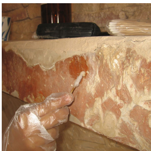
شکل ۳۶. پاکسازی گچبری به روش شیمیایی با الکل اتانول (عکس از نگارنده)
