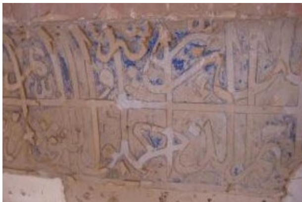
شکل ۲۳. تیره و چرک شدن سطح کتیبه در اثر آلودگی های محیطی (عکس از نگارنده)
