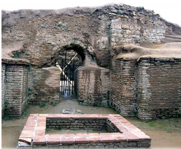
شکل ۱۴. از بالا به پایین تصاویری از رطوبت صعودی و نزولی ناشی از نزولات جوی بر روی دیوارها و کف بناها باعث سست شدن مصالح و ملاط‌ها و همچنین شرایط را برای رشد گیاهان و حضور جانوران فراهم می‌نماید. (عکس‌ها از آرشیو پایگاه تخت سلیمان)
