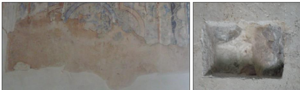
شکل ۳. راست: سونداز برای مشخص کردن تکیه‌گاه، سنگی؛ چپ: لایه بستر گچی با استفاده از مخلوط رنگ‌دانه‌های ابراء، به رنگ قرمز کم‌رنگ
