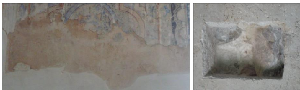
شکل ۳. راست: سونداز برای مشخص کردن تکیه‌گاه، سنگی؛ چپ: لایه بستر گچی با استفاده از مخلوط رنگ‌دانه‌های اخرا، به رنگ قرمز کم‌رنگ
