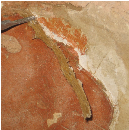
شکل ۳۴. پاکسازی گچبری به شیوه مکانیکی با تیغ بیستوری (عکس از نگارنده)
