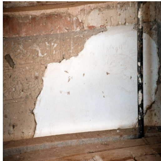
شکل ۳۲. مرمت غلط کتیبه گچبری با پر کردن کمبودها به شکل ناشیانه با گچ که موجب زشت و بد نما شدن سطح کار شده (عکس از نگارنده)
