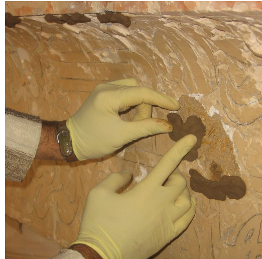
شکل ۳۷. ایجاد سونداژ و قرار دادن نوارهای گلی در اطراف برای تزریق محلول استحکام بخش (عکس از نگارنده)
