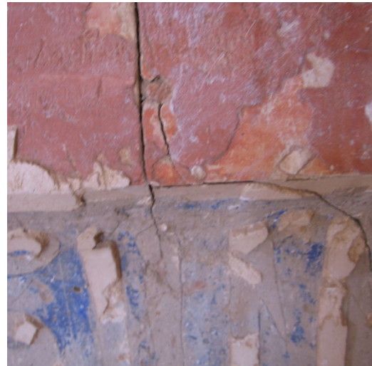
شکل ۲۴. ایجاد شکاف در سطح کتیبه گچبری تزئینی (عکس از نگارنده)
