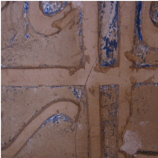
شکل ۲۵. ایجاد ترک در سطح کتیبه گچبری تزئینی (عکس از نگارنده)
