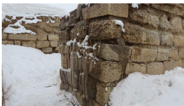
شکل ۱۳. از بالا به پایین تصاویری از یخ‌بندان و هوازگی سنگ‌ها ناشی از نزولات جوی بر روی دیوارها (عوارض این مشکلات شامل تورم و پوسته‌شدن سنگ‌ها)، (عکس‌ها از آرشیو پایگاه تخت سلیمان)
